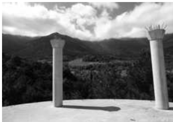
Рис. 3. Вид колонн 3-го этажа незавершенного строительством здания
