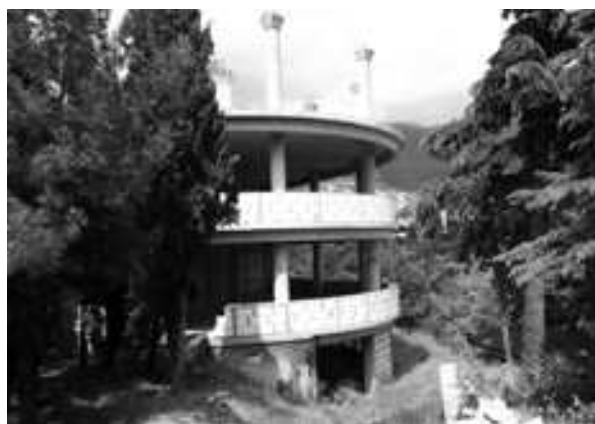
Рис. 2. Фрагмент фасада в осях А-В незавершенного строительством здания
