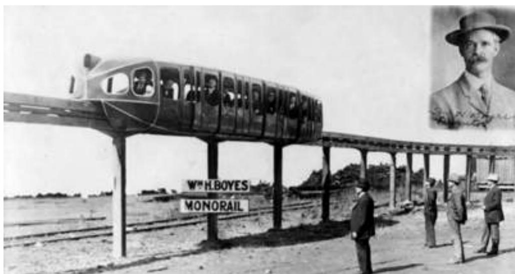
Рис. 1. Испытания монорельса Уильяма Бойеса, г. Сиэтл, 1911 г. (flickr.com)
