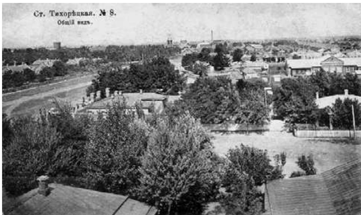
Рис. 2. Историческая застройка ст. Тихорецкой. Начало XX в.
