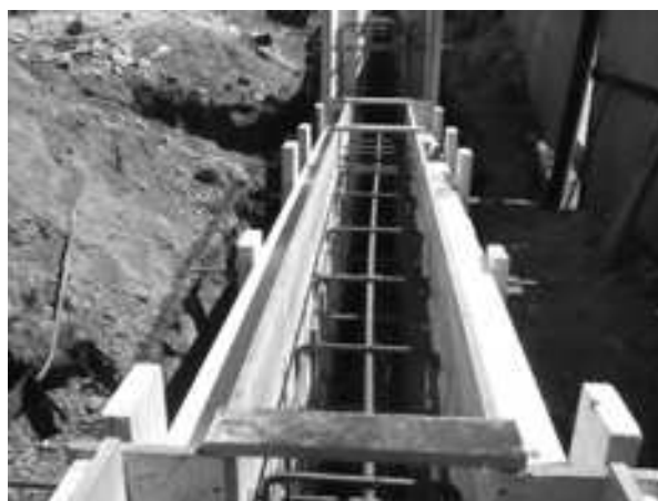
Рис. 8. Опалубка ростверка
