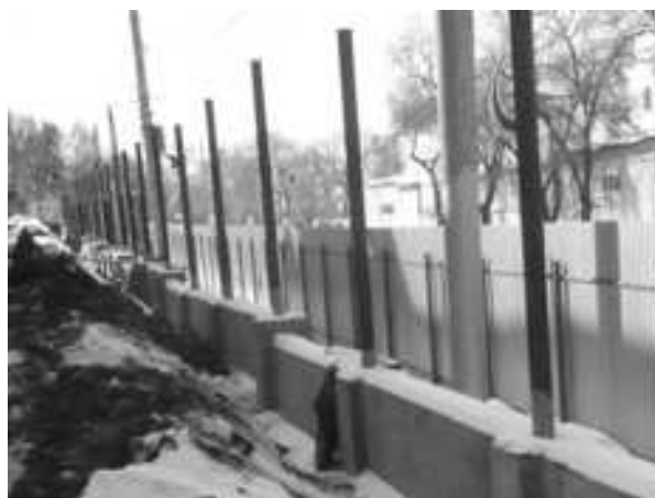
Рис. 5. Готовый ростверк со стойками под кирпичные колонны стены ограждения
