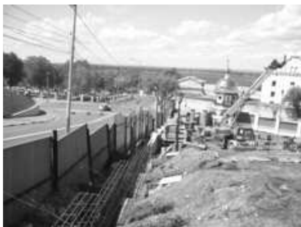
Рис. 6. Общий вид строительной площадки второго участка
