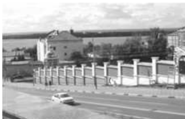
Рис. 9. Завершение отделочных работ
