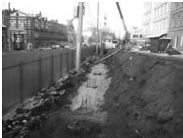
Рис. 3. Общий вид стройплощадки первого участка
