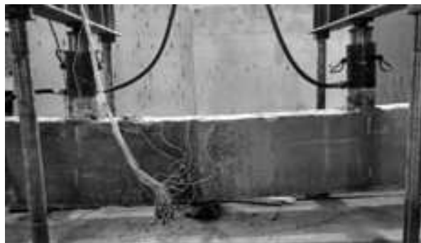
Рис. 4. Разрушение опытного образца по нормальному сечению
