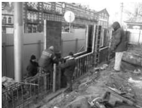
Рис. 4. Монтаж опалубки по арматурному каркасу (по арматурному каркасу навит греющий провод)
