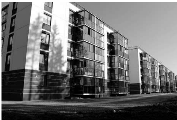
Рис. 2. Жилой дом из легкобетонных панелей
