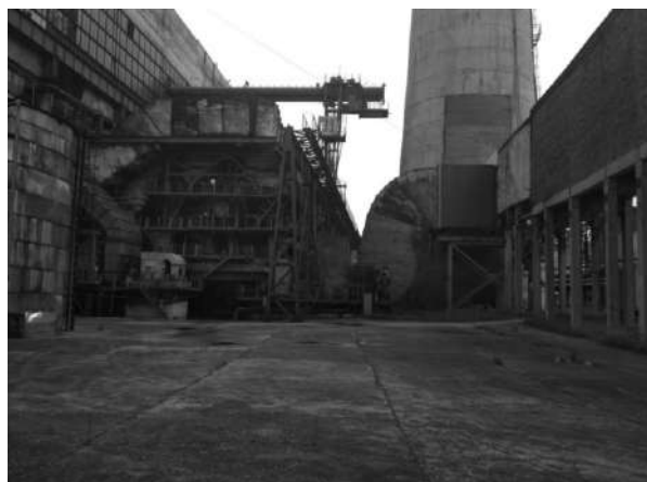
Рис. 3. Площадка для установки дымососа
