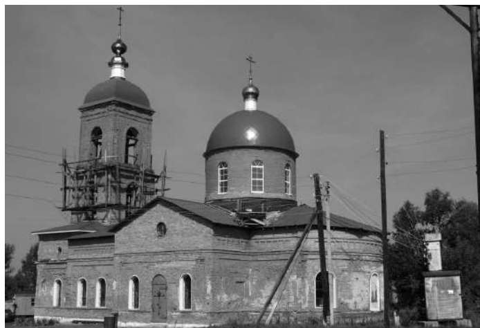
Рис. 3. Общий вид здания (фото с сайта http://kosma-i-damian.cerkov.ru/ )
