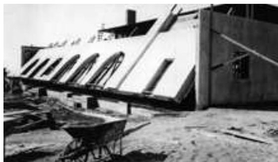
Рис. 5. Общественный дом Ла-Холья, 1915 г., арх. Ирвинг Джон Гилл (фото 1920-х гг., lajollalight.com) и технология tilt-slab (монтаж поворотом) (1914 г., UC-Santa Barbara Architecture and Design Collections)
