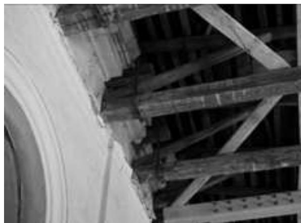
Рис. 11. Вид несущих конструкций крыши здания Дворянского собрания
