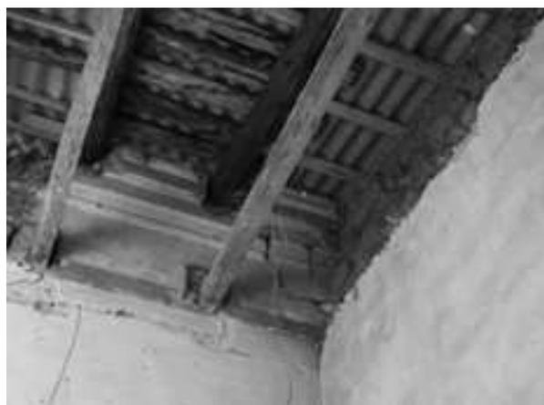
Рис. 8. Вид разрушения карнизной части стены здания Дворянского собрания в осях 2-Д
