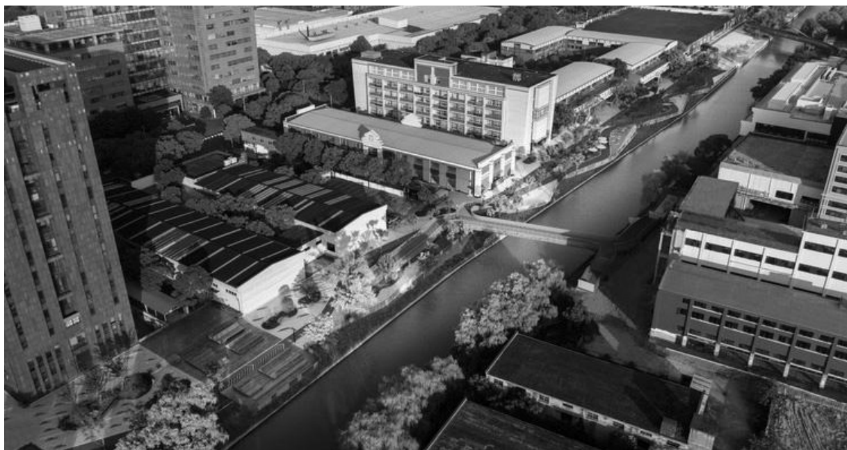
Рис.1. Реконструкция набережной Минханг / SPARK Architects
