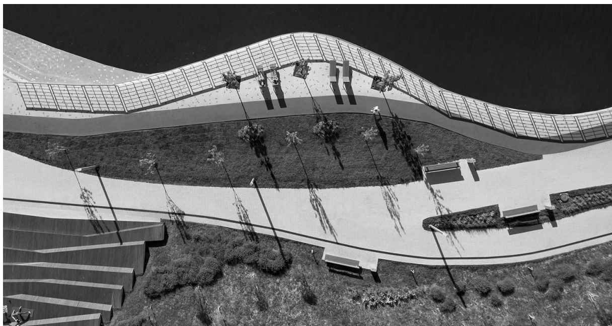
Рис. 3. Набережная в Павшинской Пойме в подмосковном Красногорске. Архитектурное бюро Basis
