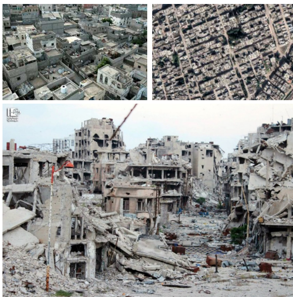
Рис. 4. Район Баба Амр, г. Хомс : фотографии, показывающие городскую планировку этого района и факт разрушения (фото А. Юнис)
