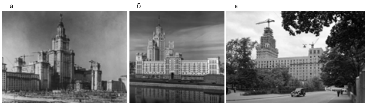
Рис. 4. Высотные здания в Москве: а – строительство здания МГУ, Ленинские горы, 1951 г.; б – высотное здание, Котельническая набережная, 1950 г.; в – высотное здание, пл. Лермонтовская, 1950 г.
