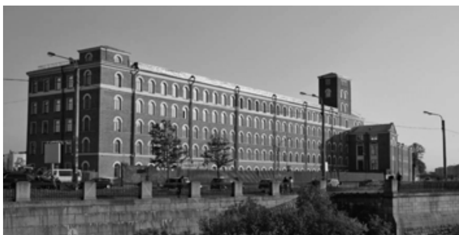
Рис. 6. «Ткачи». Общий вид со стороны Обводного канала
