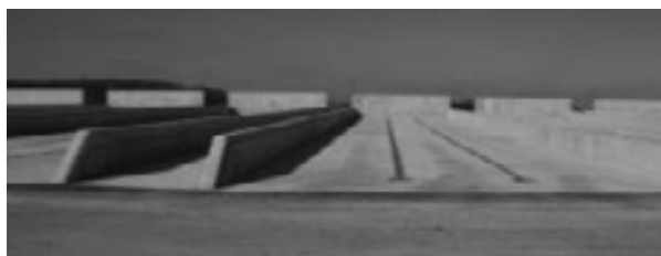
Рис. 7. Отвод поверхностных стоков
