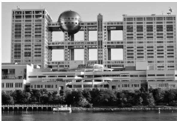
Рис. 6. Здание Fuji TV в Токио
