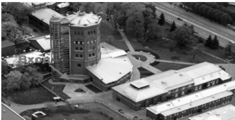
Рис. 1. Бывшая Главная станция Санкт-Петербургских городских водопроводов. В настоящее время Музей Воды
