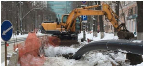
Рис. 6. Строительно-монтажные работы на Волжском проспекте по реновации бытовой канализации диаметром 300 мм
