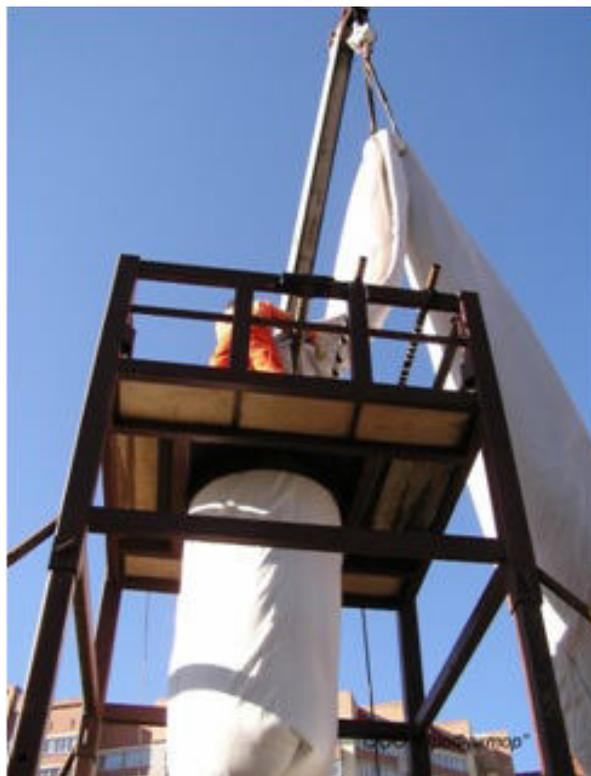
Рис. 1. Выполнение работ на улице Советской Армии по подаче гибкого полимерного рукава в колодец ремонтного участка трубопровода с применением монтажной вышки и автокрана в процессе санации коллектора дождевой канализации
