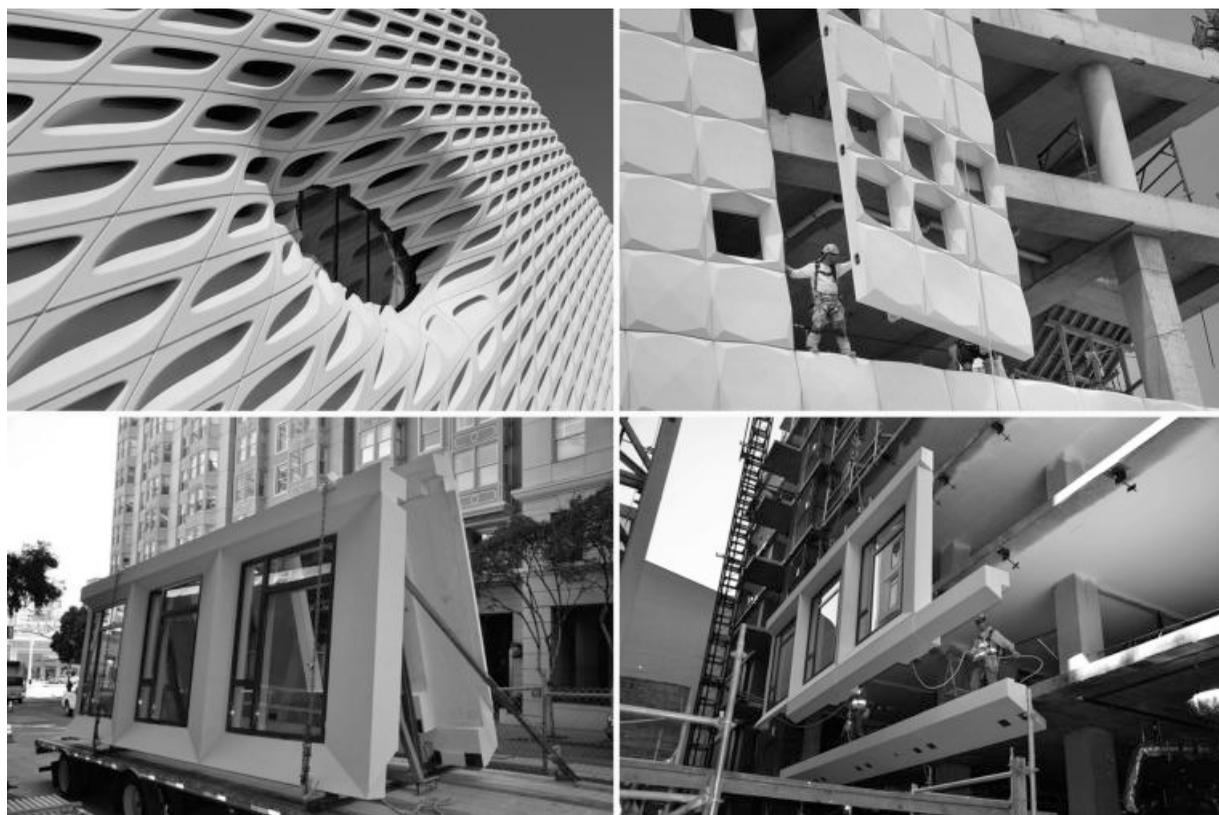
Рис. 3. Примеры использования стеклофибробетона в фасадных панелях
