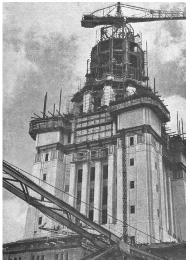
Рис. 2. Строительство первых высотных зданий в Москве при помощи самоподъемных кранов
