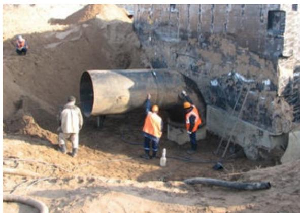
Рис. 4. Врезка нового канализационного коллектора 1400 мм в камеру переключения на выходе трех джокеров через р. Самару в процессе реконструкции Безьямьинского коллектора
