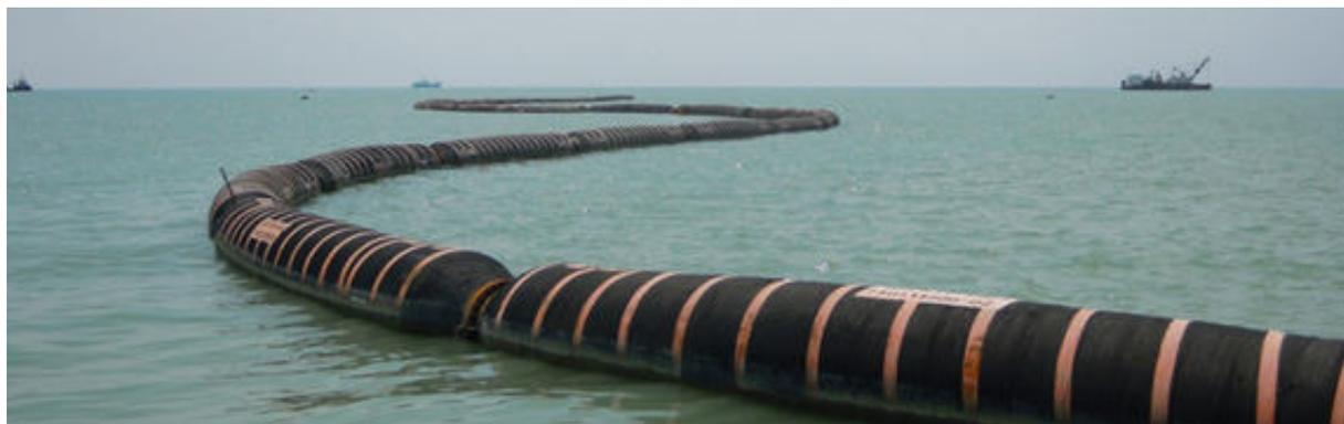
Рис. 2. Подготовленный к погружению нефтепровод
