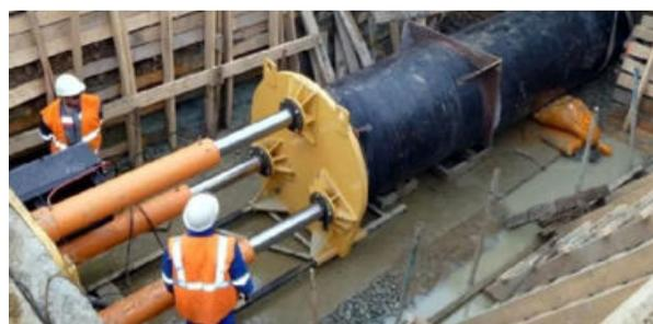
Рис. 5. Укладка трубопроводов методом продавливания
