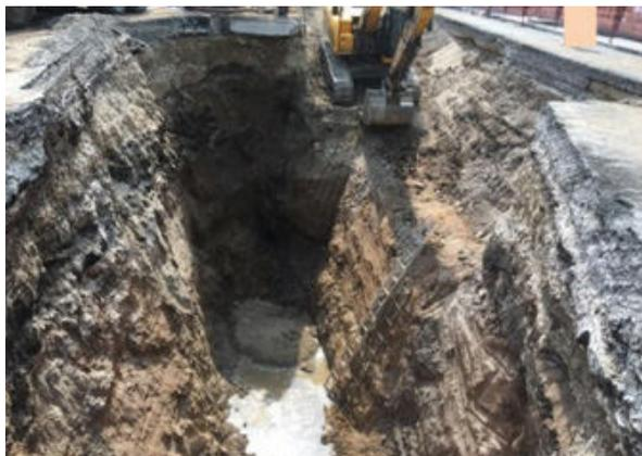
Рис. 5. Разработка траншеи экскаватором на Волжском проспекте в процессе перекладки аварийного участка бытовой канализации диаметром 300 мм
