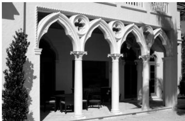
Рис. 7. Архитектурный сборный железобетон от фирмы «Premier Stoneworks»
