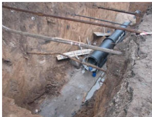
Рис. 2. Строительно-монтажные работы на улице Псковской по демонтажу старых и укладке новых труб дождевого коллектора 1000 мм
