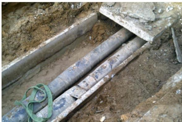
Рис. 1. Трубопроводы тепловой сети в непроходном канале с песчаной подсыпкой
