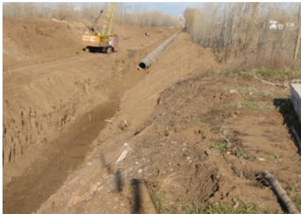
Рис. 3. Строительство нового коллектора диаметром 1400 мм вдоль Южного шоссе в процессе реконструкции Безьямьинского коллектора на левом берегу р. Самары
