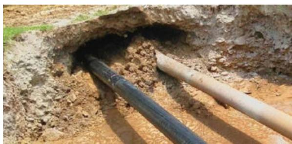
Рис. 4. Укладка трубопроводов методом прокола
