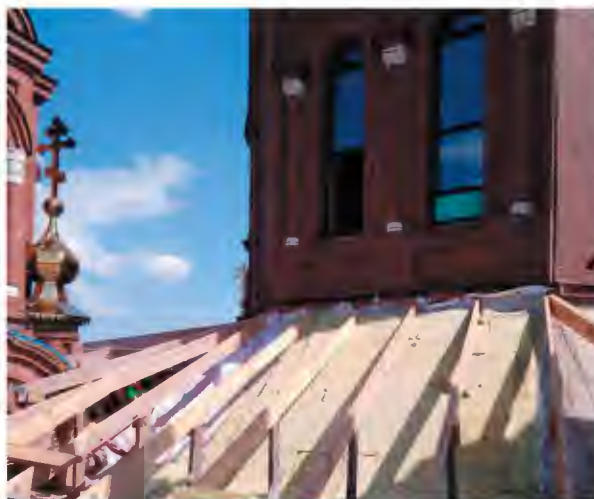
Рис. 9. Монтаж стропильных конструкций и утепление кровли; монтаж металлического фальцевого покрытия кровли
