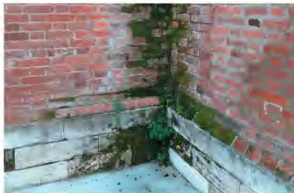
Рис. 4. Фотофиксация до производства работ: а, б – конструктивные трещины по фасаду и вскрытому фундаменту; в – отсутствие отливов; г – биопоражения исторической кладки
