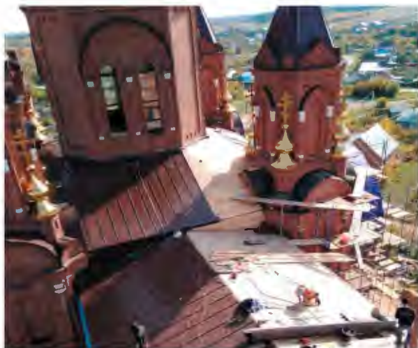
Рис. 9. Монтаж стропильных конструкций и утепление кровли; монтаж металлического фальцевого покрытия кровли
