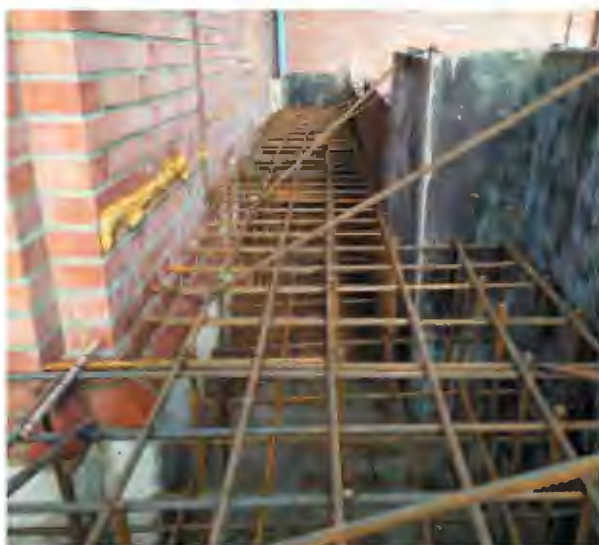
Рис. 6. Усиление фундаментов путем устройства монолитного железобетонного ростверка по периметру колокольни и объема трапезной
