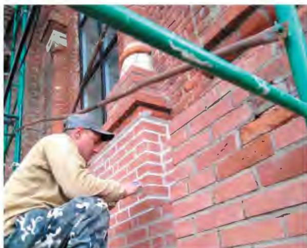
Рис. 7. Расшивка швов лицевого ряда современной кладки; заделка швов кладки
