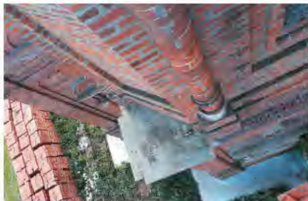
Рис. 4. Фотофиксация до производства работ: а, б – конструктивные трещины по фасаду и вскрытому фундаменту; в – отсутствие отливов; г – биопоражения исторической кладки
