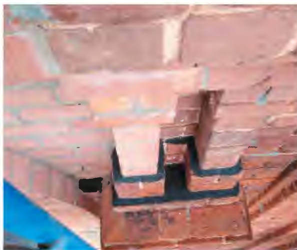
Рис. 10. Промазка выступающих декоративных элементов фасада гидроизолирующей мастикой; установка металлических отливов по декоративным элементам фасадов здания
