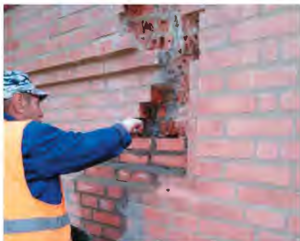
Рис. 8. Демонтаж лицевого ряда кладки; восстановление лицевого ряда кладки в местах прохождения конструктивных трещин
