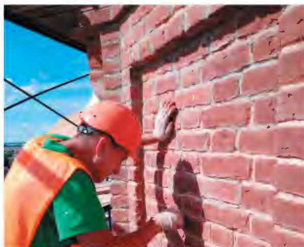
Рис. 7. Расшивка швов лицевого ряда современной кладки; заделка швов кладки
