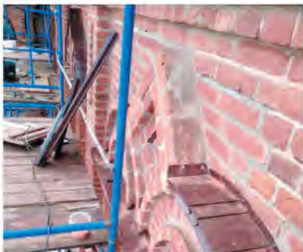
Рис. 10. Промазка выступающих декоративных элементов фасада гидроизолирующей мастикой; установка металлических отливов по декоративным элементам фасадов здания
