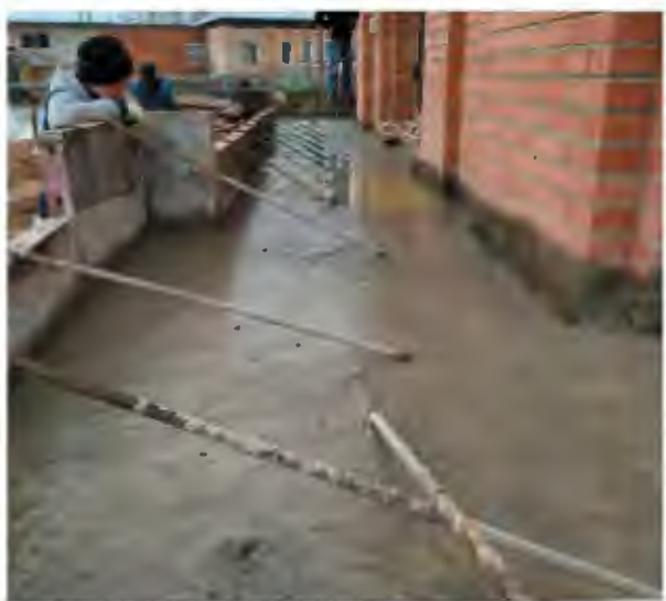
Рис. 6. Усиление фундаментов путем устройства монолитного железобетонного ростверка по периметру колокольни и объема трапезной
