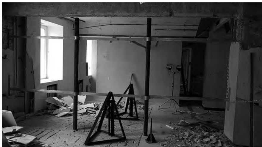
Рис. 8. Испытание № 2. Общий вид испытываемых конструкций со стороны первого этажа
