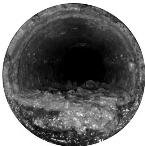
Рис. 1. Колебание уровня наполнения трубы с отложениями осадка в лотковой части:
