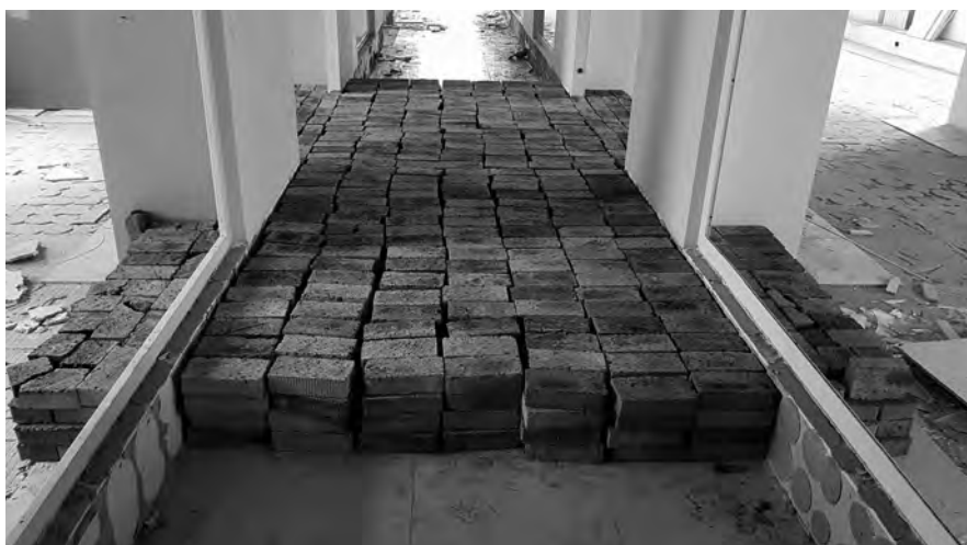
Рис. 7. Испытание № 1. Загруженный полной нагрузкой участок перекрытия (вид со стороны второго этажа)
