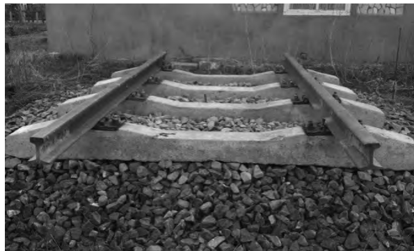
Рис. 3. Участок экспериментального железнодорожного пути
