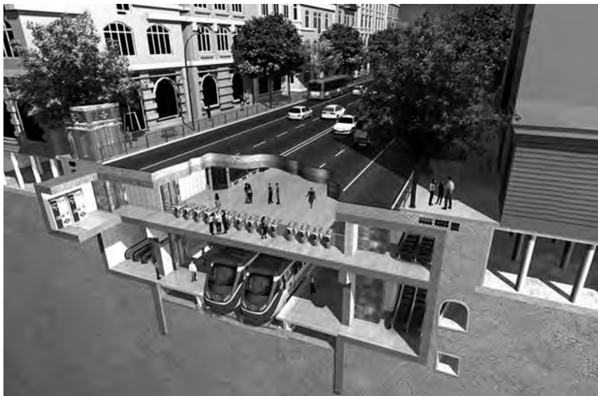
Рис. 6. Двухуровневая станция метрополитена, построенная по испанской технологии. Мехико
