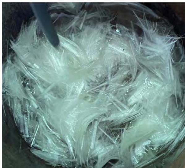
Рис. 4. Добавление фибры в часть воды затворения
