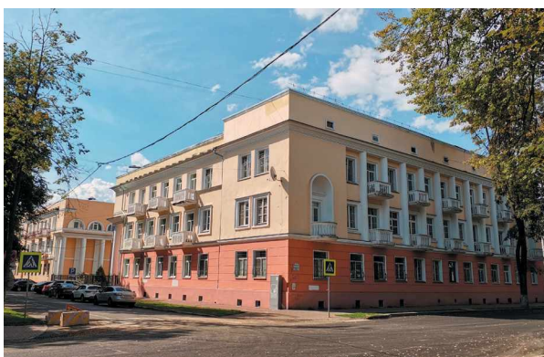
Рис. 6. 38-квартирный жилой дом завода СК-1, Волжская набережная, 25/22, г. Ярославль (1935–1937)
