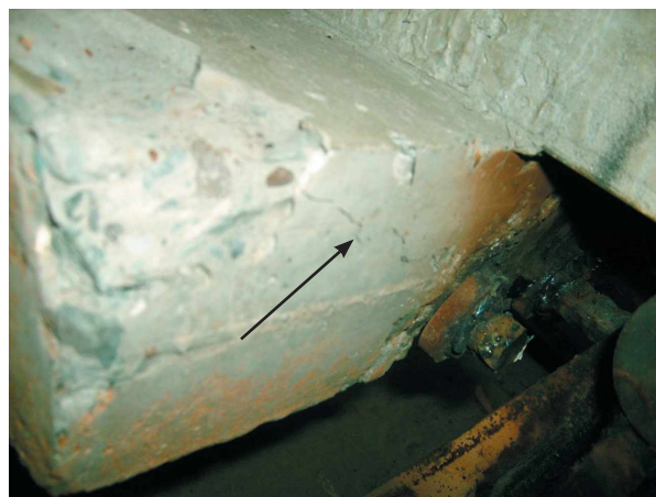
Рис. 5. Дугообразная трещина на торце полки
