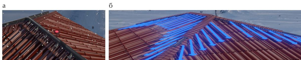
Рис. 1. Принципиальная конструкция устройства для предупреждения снегонакопления на кровлях зданий: а – без защитного козырька; б – с защитным козырьком (стрелками показано направление воздушных потоков из сопловых распределителей)
