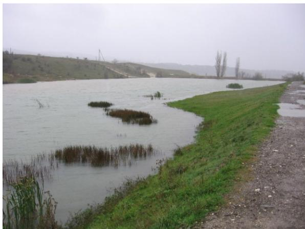
Рис. 1. Пруд-накопитель для воды после промывки фильтров и продувки отстойников ВОС «Приятное свидание» [2]
