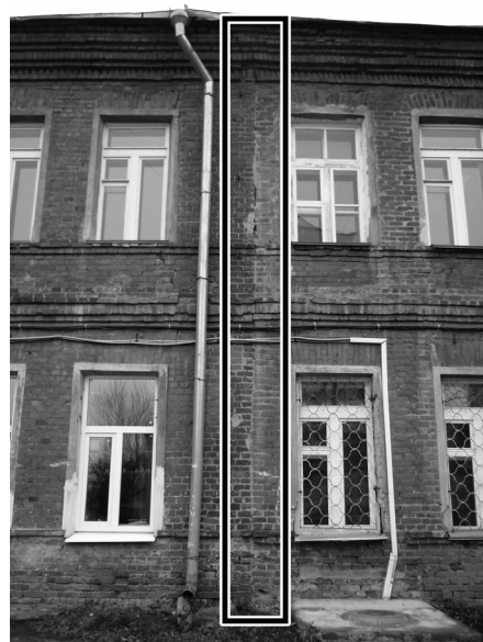
Рис. 8. Вертикальный стык кирпичной кладки на дворовом фасаде здания. Фото Е.А. Чернышевой, декабрь 2020 г.
