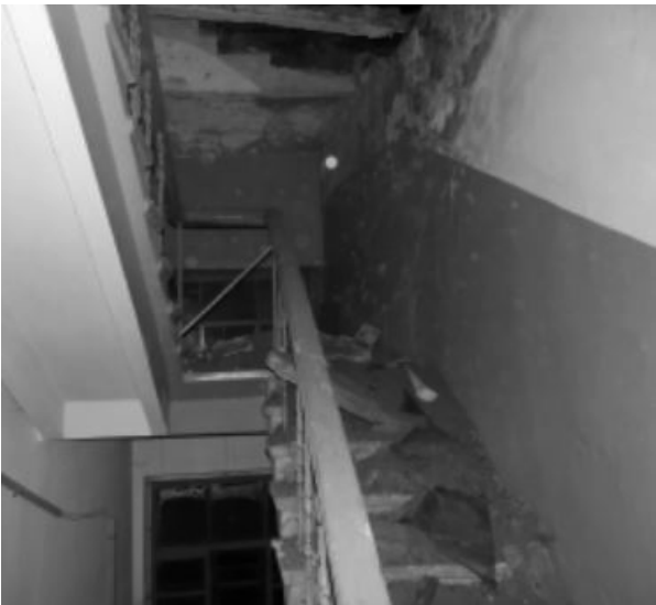
Рис. 1. Обрушение 6 м² перекрытия лестницы: г. Кострома, пр-т Текстильщиков, д. 1 Fig. 1. Collapse of 6 m² of stairs: Kostroma, Tekstylshchikov Ave., 1
