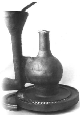
Отливка ротора с литниково-питающей системой
