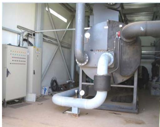
Рис. 7. Установка утилизации тепла отходящих газов
