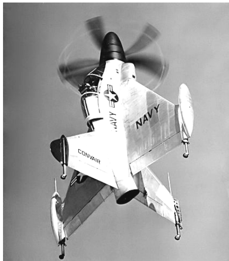
Рис. 7. БАС с вертикальным взлетом и горизонтальным полетом Convair XFY-1 Pogo
