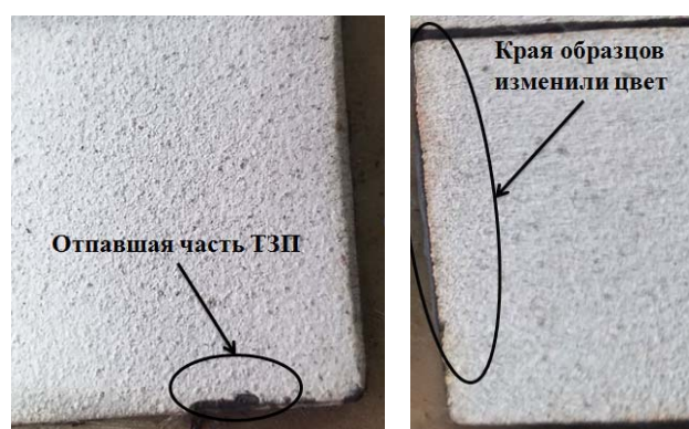
Рис. 4. Дефекты при испытаниях на жаропрочность
