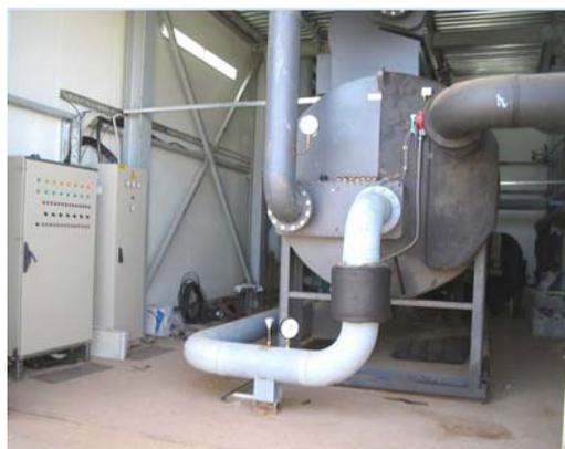
Рис. 7. Установка утилизации тепла отходящих газов
