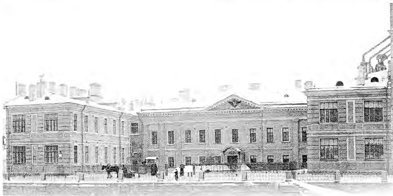
Рис. 1. Фасад прежнего Повивального института
